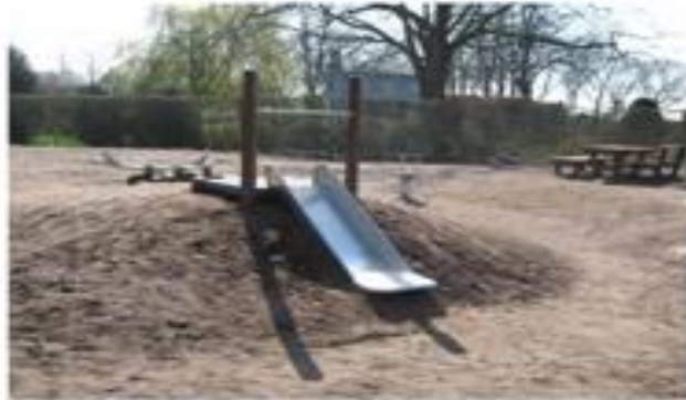
Taludglijbaan (rvs) aanzethoogte: 95 cm Vrije valhoogte 50 cm leverancier: Goede Speelprojecten / Replay o.g.
