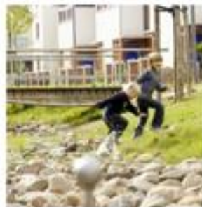
Rivierkeien Plaatsing: 1/3 deel ingegraven Doorsnede tussen 25-40 cm Aannemer o.g.
