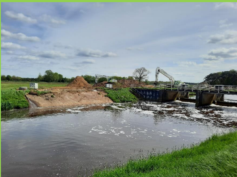
Aanleg meandermonding bij stuw Galder vordert.
